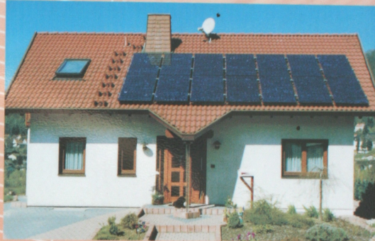
Haus mit Solarmodul
